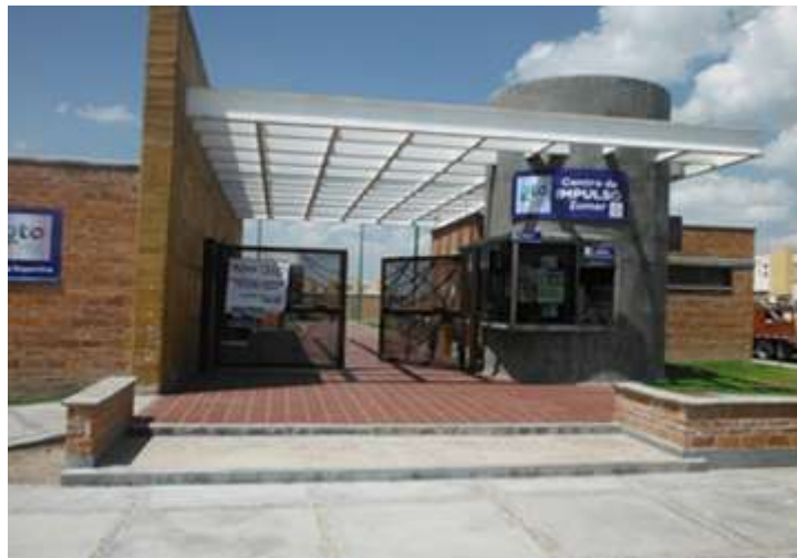
Centro Comunitario de Impulso Social Villas del Bajío
